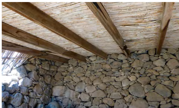
Mampostería tipo B ordinaria a hueso en alpendre, Las Lagunas, Santa Lucía de Tirajana.
