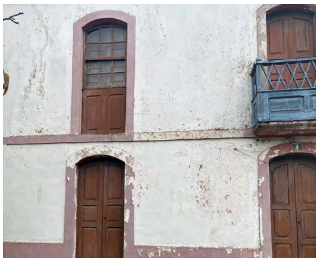
Relieves de fachada realizados con cemento, invariante II con influencia urbana, Las Lagunetas, San Mateo.
