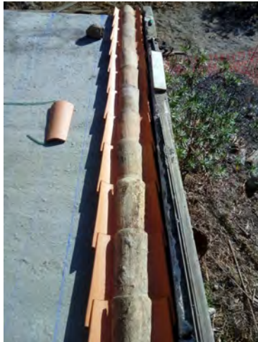
Imagen de colocación de tejas originales recuperadas, cobijas, con nuevas tejas a canal (las tejas originales eran insuficientes por deterioro del tejado original), Casas del Fondo, Bandama.
