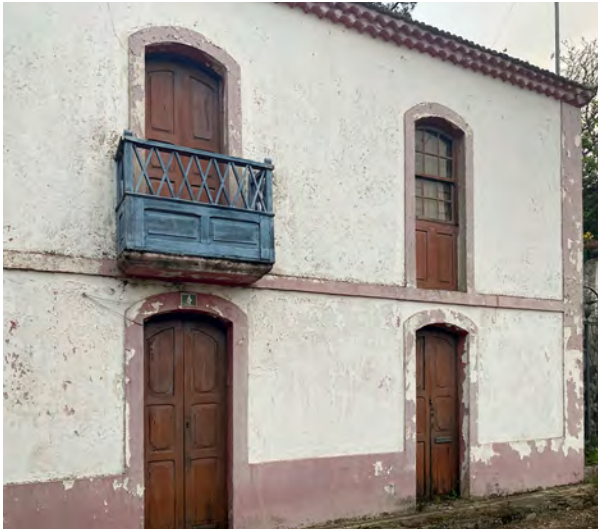
Pequeño balcón de madera en vivienda de invariante tejado a cuatro aguas con influencia urbana, Las Lagunetas, San Mateo.
