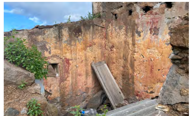
Detalle de interior de cocina, donde se aprecia el muro encajado y enjalbegado directamente sobre la mampostería.
