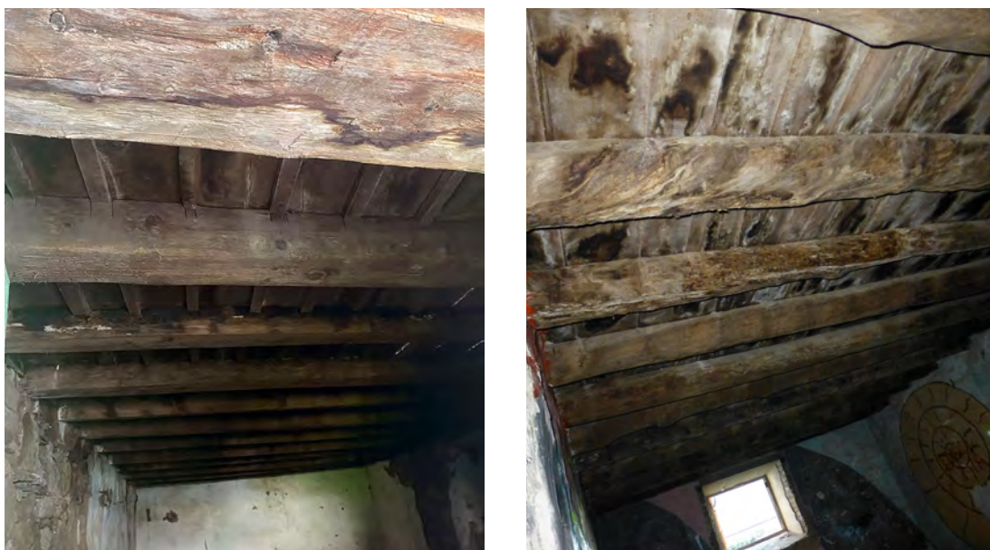
Forjado intermedio con viguetas y correas, Molino de Viento, Mogán (izquierda), y forjado intermedio sobre rollizos de madera, San Felipe, Guía (derecha).
