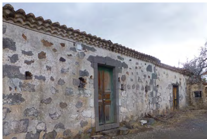
Viviendas adosadas por muro hastial, Hoya Grande, Tunte.
