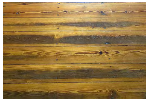
Tarima de madera rehabilitada.
