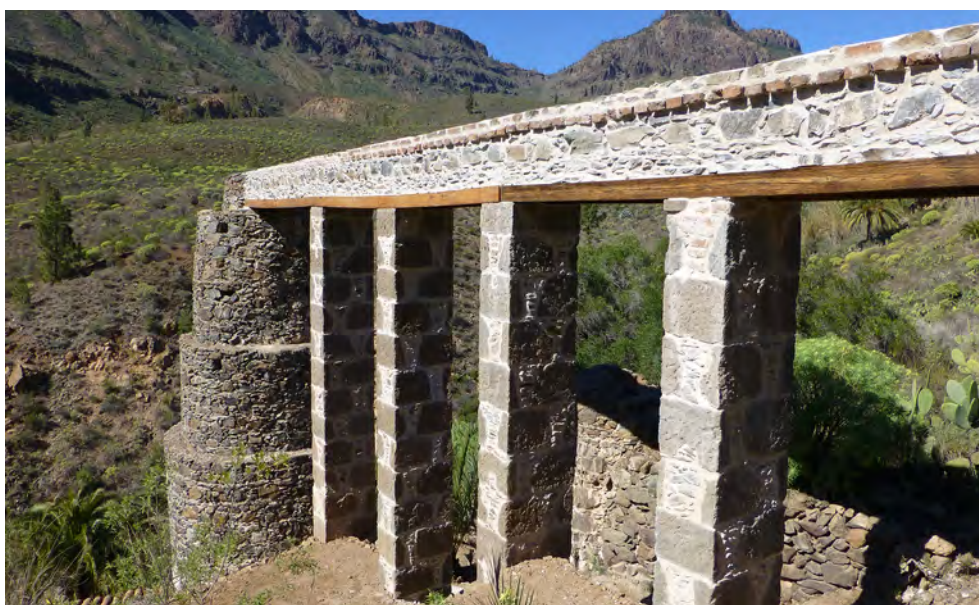
Pilastras de sillería ripiada con relleno mixto, Acueducto del Molino de los Cazorla, Fataga, San Bartolomé de Tirajana.
