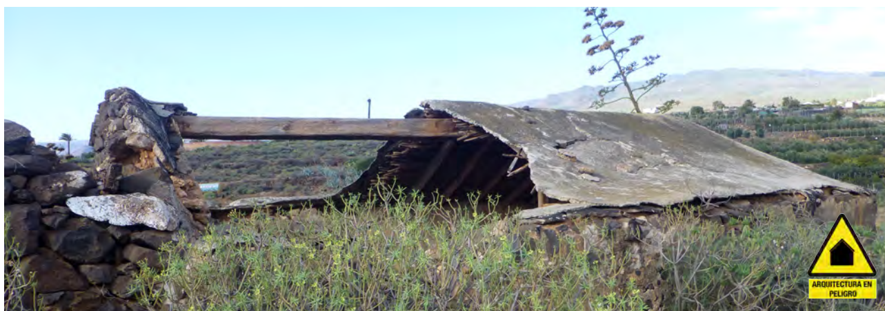
Casa con cubierta a dos aguas y torta de cal. El Lirón, Ingenio.
