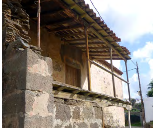
Galería parcial sobre pies derechos en vivienda de invariante II sencilla, con aprovechamiento del bajo de galería, Trasmontaña, Arucas.
