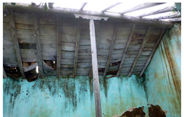
Interior de vivienda invariante I sencilla cubierta de tierra, revestida con mortero de barro y albeado, La Humbridilla, Mogán. Interior de vivienda invariante I sencilla cubierta de tejas, revestida con mortero de cal y pintado en verde, La Humbridilla, Mogán.
