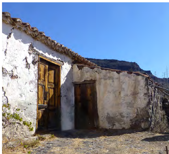
Puerta principal de hoja doble abisagrada y puerta de cocina de dos hojas con gozne , Las Lagunas, Santa Lucía de Tirajana.
