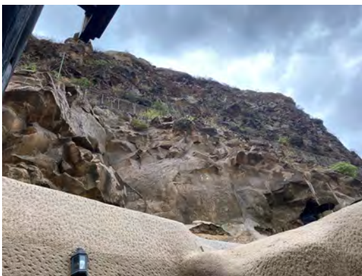
Mimetización de las instalaciones en el interior y muy adecuada consolidación de risco superior.
