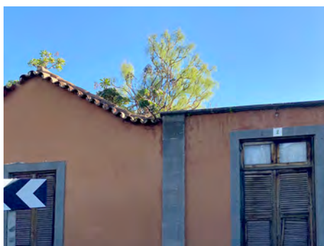
Remate hacia muro hastial con tejas en punta, Santa Brígida.
