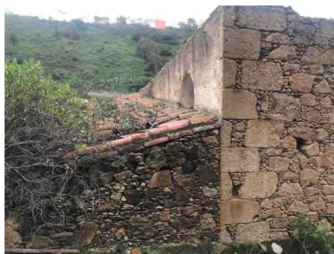
Sillares y mampostería ordinaria careada de toba (derecha) y mampostería ordinaria de mampuestos de basalto (izquierda), Casa Román, Las Palmas de Gran Canaria.
