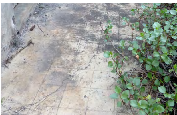
Pavimento de cemento fratasado.
