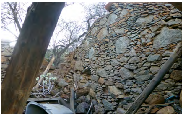
Mampostería tipo A, cocina en Hoya Grande, Tunte.
