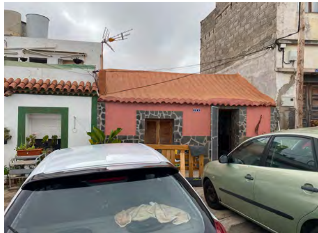
Aplacado de lajas en zócalo, jambas y dinteles de huecos.
