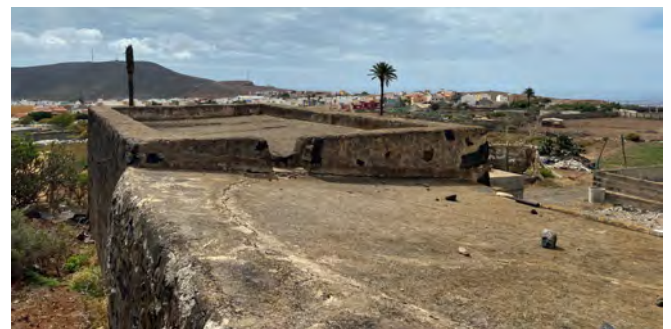
Cubierta de torta de cal, Agüimes.
