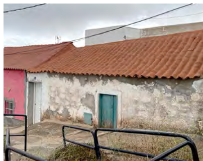
Cubierta de tejas reparadas con pintura impermeabilizante.
