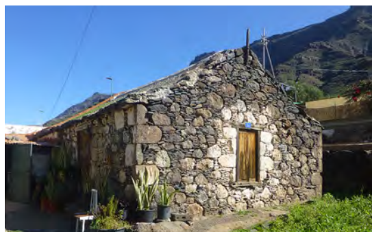
Vivienda con cubierta de tierra y lajas, Molino de Viento, Mogán.
