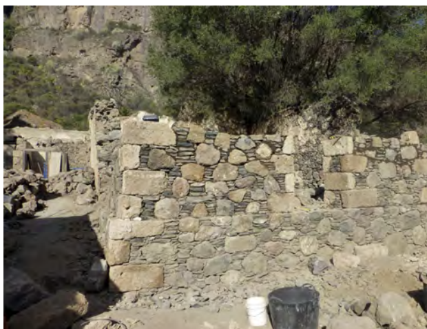
Muro desplomado (izquierda) y muro totalmente reconstruido con la misma técnica del original (derecha).
