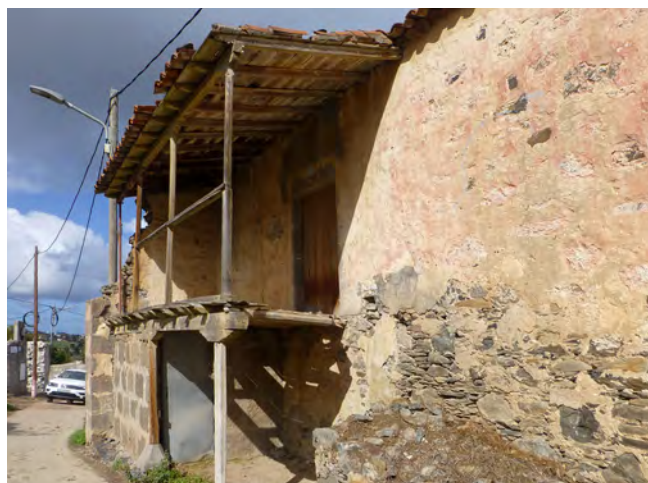
Escalera de mampostería (desaparecida) y galería parcial adosada a muro noroeste, La Montañeta, Arucas.
