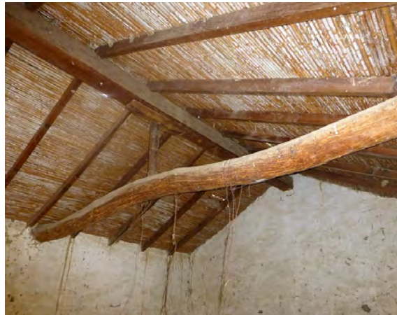
Apeo de hilera con viga transversal a un tercio, La Montañeta, Arucas.
