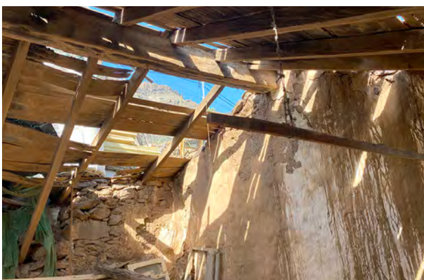
Interior de vivienda invariante I sencilla cubierta de tierra, revestida con mortero de barro y albeado, La Humbridilla, Mogán. Interior de vivienda invariante I sencilla cubierta de tejas, revestida con mortero de cal y pintado en verde, La Humbridilla, Mogán.
