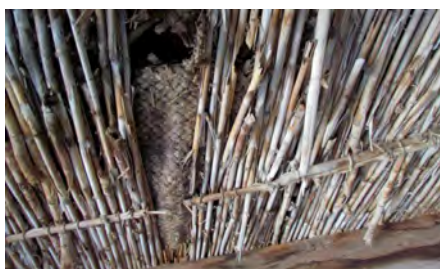
Detalle de utilización de esterilla de palma por encima de entrevigado. Fuente: Navarro González, P.T. (2012), p. 143.
