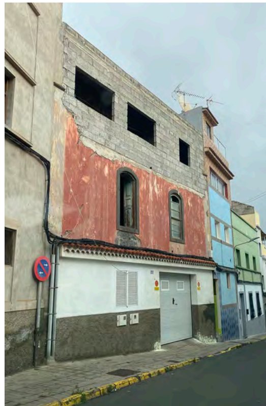
Vivienda en origen aislada, ampliada, adosada y transformada en Hoya San Juan, Arucas.
