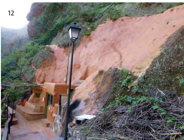
7. Eflorescencias en pavimento; 8. Caídas de enfoscados por falta de ventilación y transpiración del soporte. 9. Instalación de postes en rojo; 10-11. Filtración de aguas procedentes de pozo negro; 12. Retirada de capa vegetal y pintado con pintura plástica; 13. Casa-cueva quemada por utilización de materiales combustibles.
