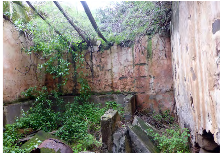
Sillares de piedra de Arucas en tina de lagar, Pino Santo, Santa Brígida.
