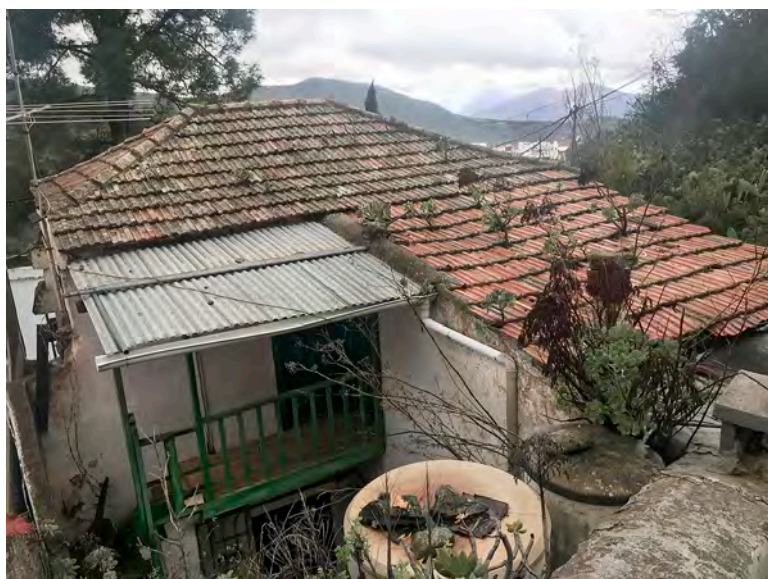
Vivienda en Juncalillo, Gáldar.
