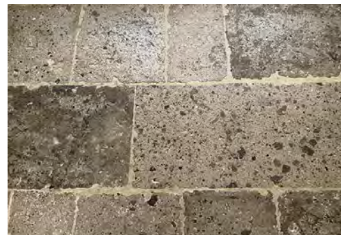
Solado, recuperado y rectificado, de piedra de Ayagaures.
