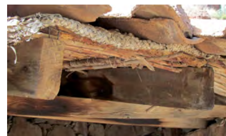
Detalle de utilización de esterilla de palma por encima de entrevigado. Fuente: Navarro González, P.T. (2012), p. 143.
