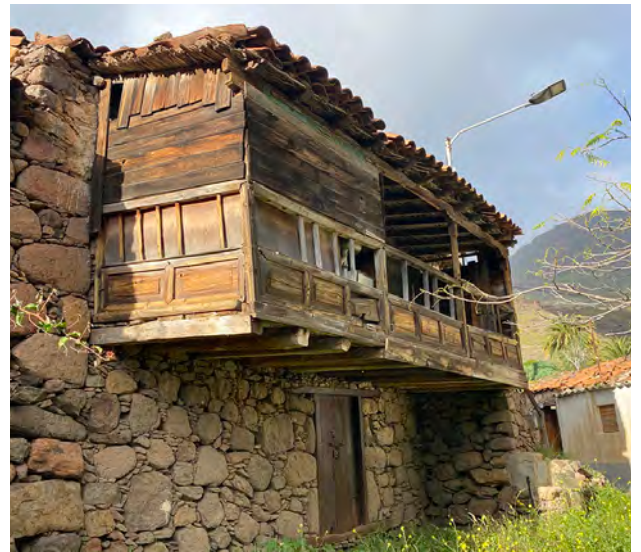
Corredor de acceso tipo balcón en viviendas de invariante cubierta a dos aguas sencillo, apoyado en ménsulas de madera, Veneguera, Mogán.
