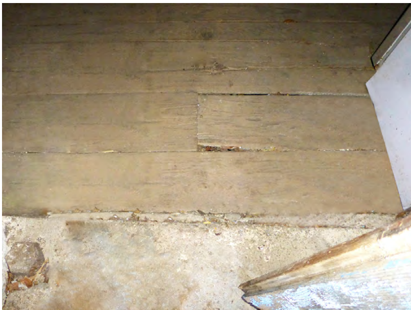
Suelo de tablas de maderas. Hoya Grande, Santa Lucía.
