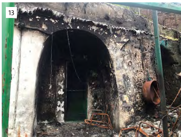
7. Eflorescencias en pavimento; 8. Caídas de enfoscados por falta de ventilación y transpiración del soporte. 9. Instalación de postes en rojo; 10-11. Filtración de aguas procedentes de pozo negro; 12. Retirada de capa vegetal y pintado con pintura plástica; 13. Casa-cueva quemada por utilización de materiales combustibles.
