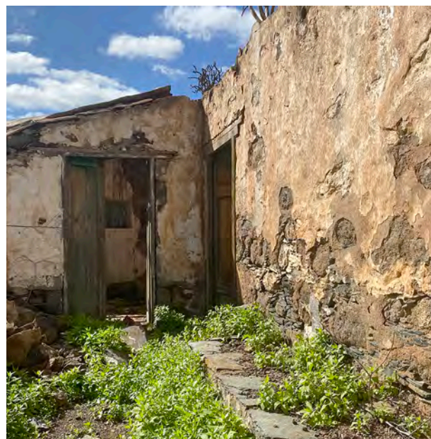
Cocina adosada a edificación principal. Molino de viento, Mogán.
