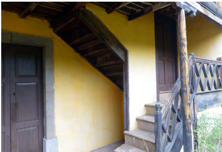
Escalera de dos tramos con primer tramo de piedra de cantería y segundo tramo de madera, Pino Santo, Santa Brígida.
