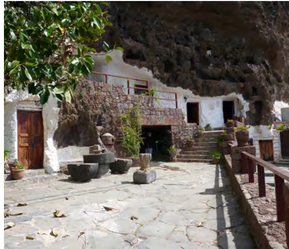
Casa de Santiago Aranda, en Artenara, convertida en museo, con todos los servicios sin alterar el valor original. El patio como punto central y distribuidor de las distintas salas.
