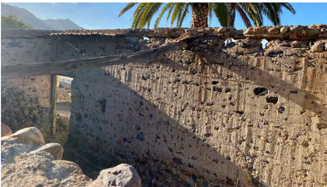
Muro cajón en cuartería en Los Cercadillos, La Aldea.
