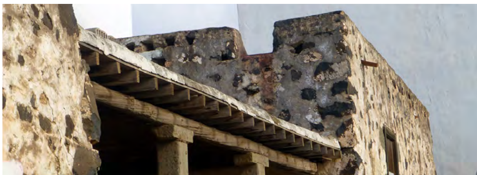
Detalle de borde de faldón en alpendre con cubierta de cal, El Lirón, Ingenio.
