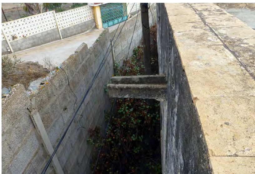
Gárgola de cantería en vivienda de invariante II sencillo en Los Rosales, Fargas.
