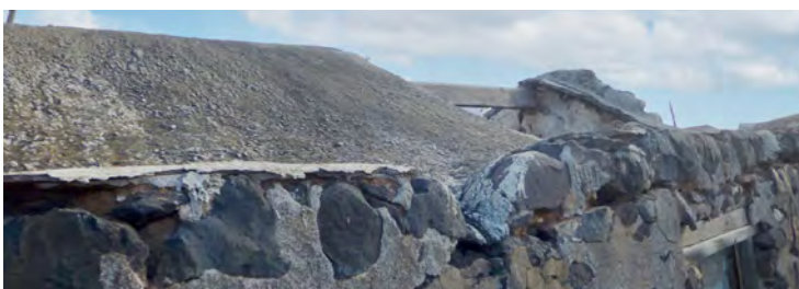
Detalle de cumbre de cubierta de cal.
