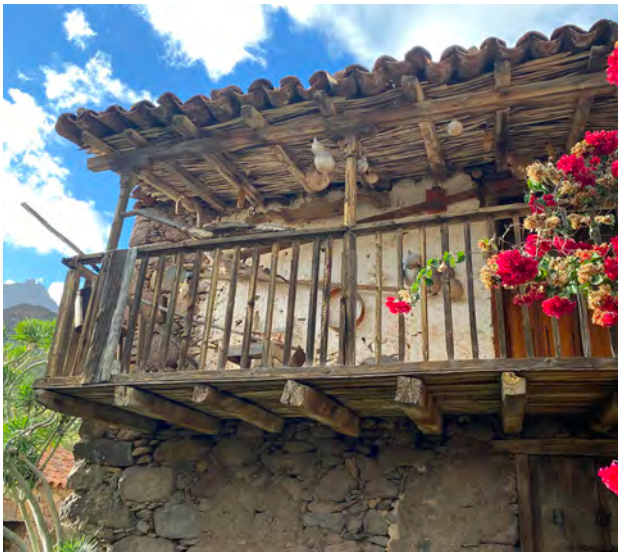
Corredor de acceso tipo balcón en viviendas de invariante cubierta a dos aguas sencillo, apoyado en ménsulas de madera, Veneguera, Mogán.
