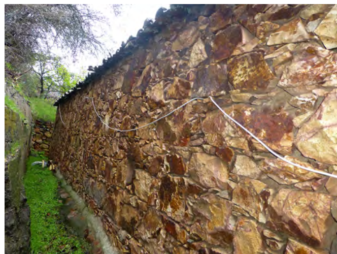
Mampostería ordinaria careada de vivienda en Coruña con piedra del lugar, Artenara.
