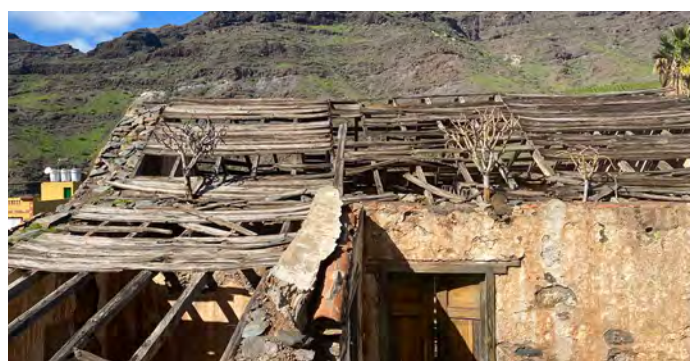
Entrevigado de tablas clavadas a los pares, Molino de Viento, Mogán.
