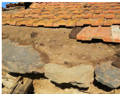
Superposición de teja plana en cubierta de tierra y lajas
