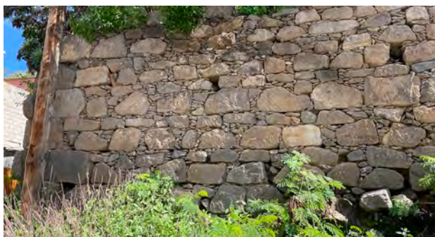
Mampostería tipo A en hiladas horizontales, Arucas.
