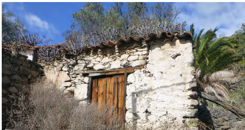
Paramento con zonas enjalbegadas directamente sobre la mampostería y con zonas encaladas con mortero de cal sin maestrear , invariante I, Temisas, Agüüimes.
