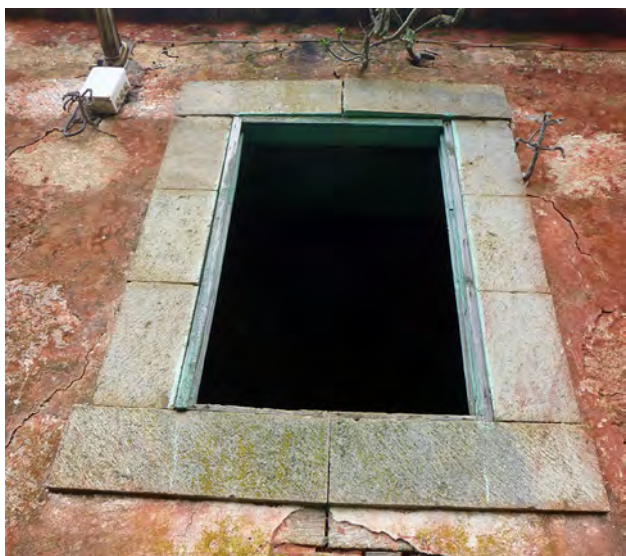
Cantería en invariante II sencillo de dos plantas: marco de cantería, La Lechucilla, San Mateo. Alféizar de cantería de Arucas labrada, La Montañeta, Arucas.
