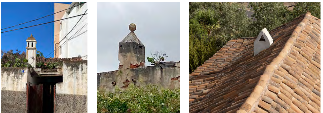
Chimenea en cocina de vivienda en Trapiche, Arucas (1), en el Mirón, Arucas (2) y en Santa Lucía (3).
