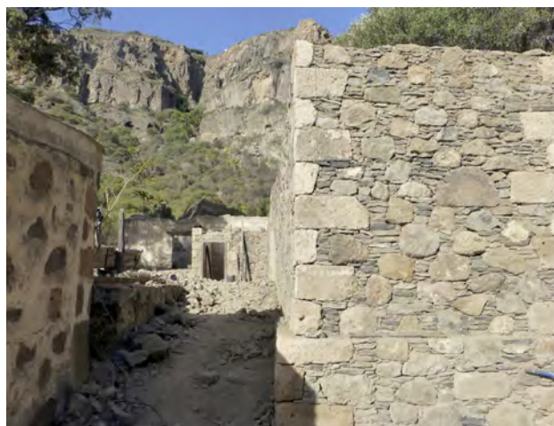
Muro desplomado (izquierda) y muro totalmente reconstruido con la misma técnica del original (derecha).
